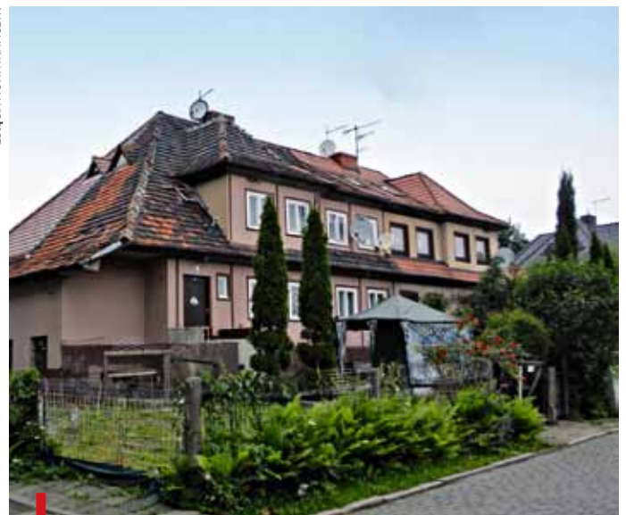
Dom stalowy przy ul. J. Szafarczyka 41-43
