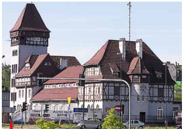
Remiza Straży Pożarnej przy ul. Stalmacha 22
