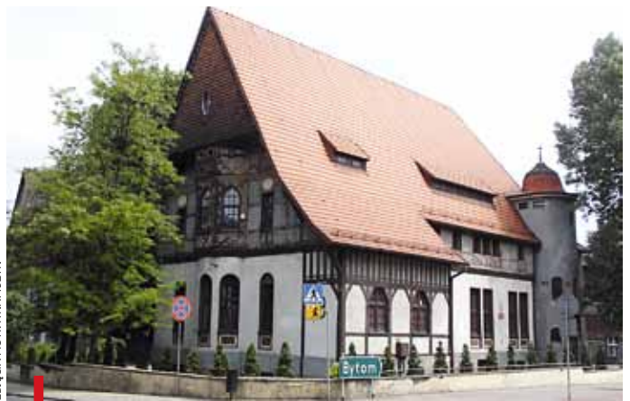
Budynek dawnego przedszkola przy ul. P. Stalmacha 9
