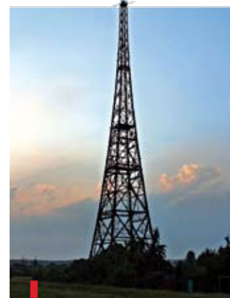
W związku z pracami remontowymi zwiedzanie gliwickiej Radiostacji w najbliższych miesiącach będzie ograniczone
