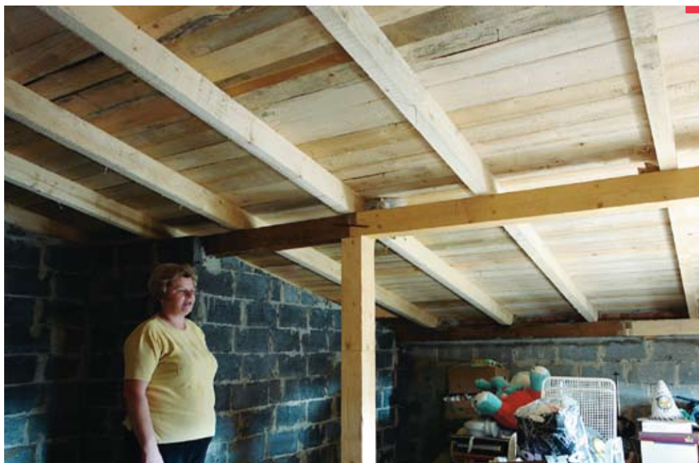
Teresa Myrcik pokazuje część poddasza, która była zupełnie zniszczona
