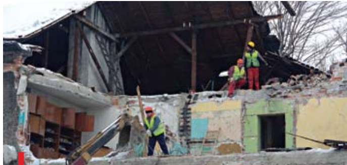
Po przeszukaniu gruzowiska przyszedł czas na rozbiórkę zniszczonej części budynku
